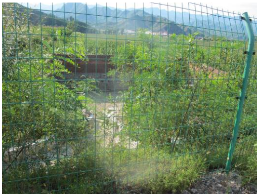
娘子关泉域路段 1#路基收集池
