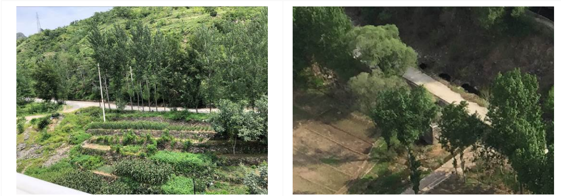
图 6.1 施工便道恢复照片
