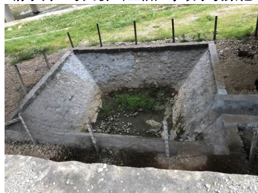
清水河 1 号大桥（右幅）事故水收集池
