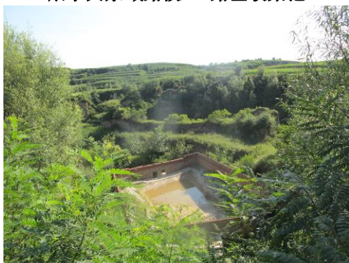
娘子关泉域路段 5#路基收集池
