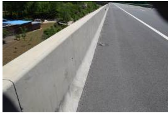
桥梁段混凝土墙式护栏
