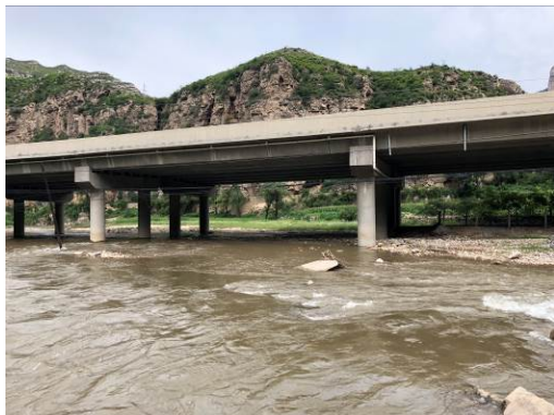
清水河 3 号大桥桥面径流收集系统
