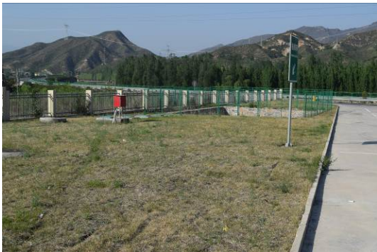
孟县北服务区西区污水处理设备
