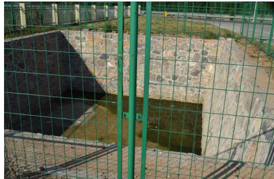
孟县北服务区西区污水收集池
