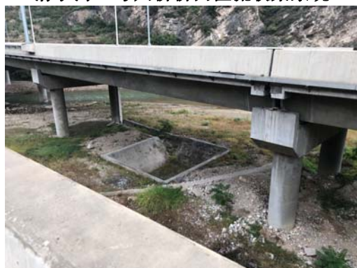
清水河 3 号大桥 2#事故水收集池
