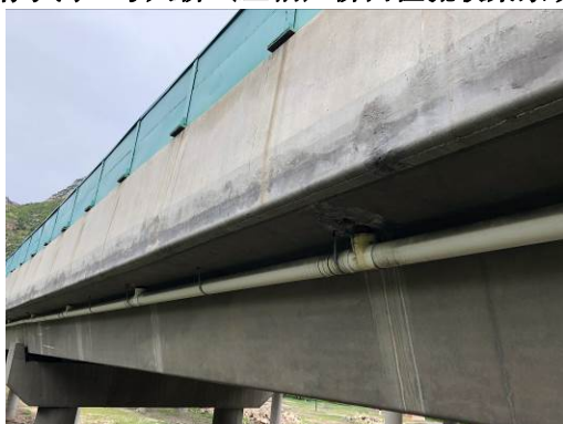
清水河 1 号大桥（右幅）桥面径流收集系统
