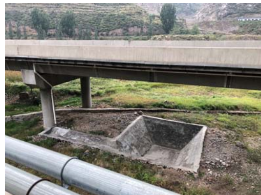
清水河 3 号大桥 1#事故水收集池
