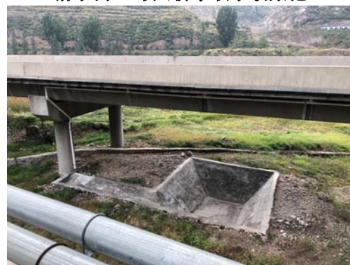
清水河 3 号大桥 1#事故水收集池
