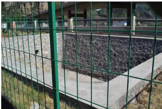
站区收集水池 (可储存事故水)
