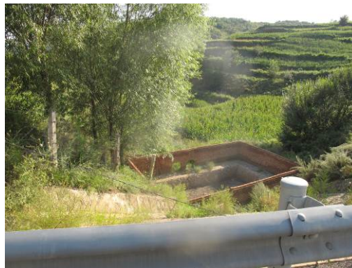
娘子关泉域路段 7#路基收集池
