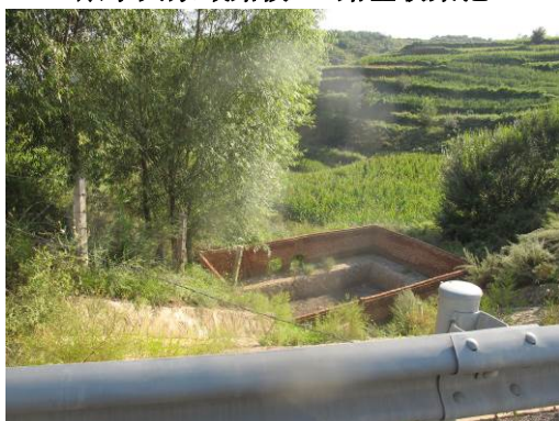
娘子关泉域路段 7#路基收集池
