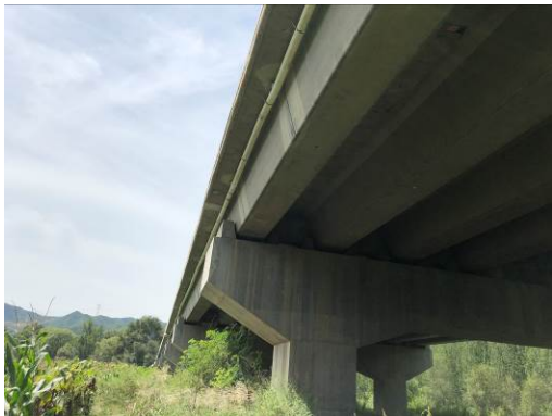
龙华河 1 号大桥桥面径流水收集系统
