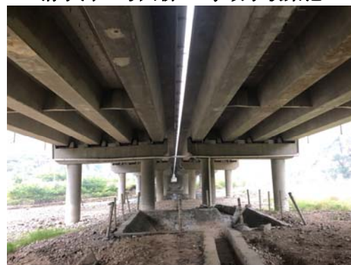
清水河 3 号大桥 3#事故水收集池
