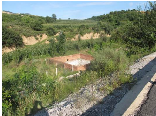
娘子关泉域路段 2#路基收集池
