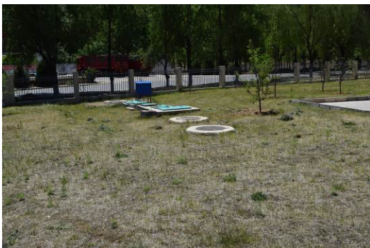
上社收费站污水处理设备
