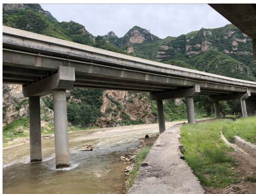
清水河 1 号大桥（左幅）桥面径流收集系统
