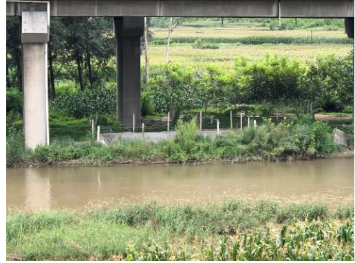
清水河 6 号大桥事故水收集池
