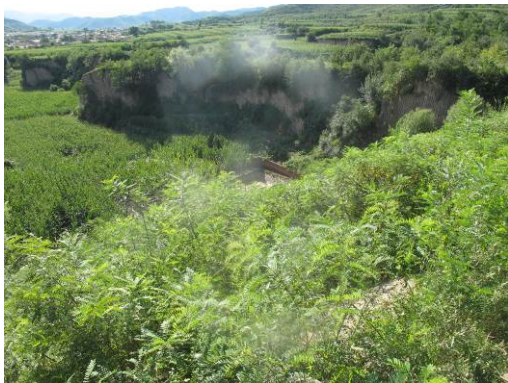
娘子关泉域路段 3#路基收集池
