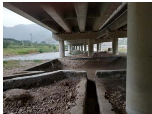
清水河 2 号大桥事故水收集池
