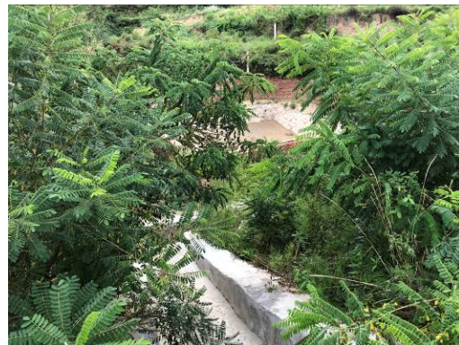
娘子关泉域路段 4#路基收集池
