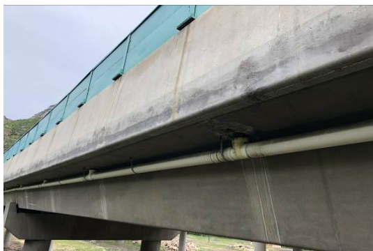
清水河 1 号大桥（右幅）桥面径流收集系统
