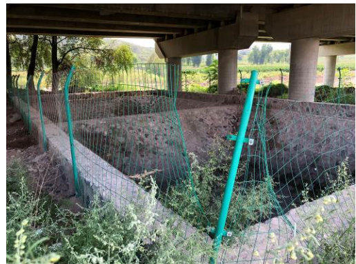
龙华河 2 号大桥事故水收集池
