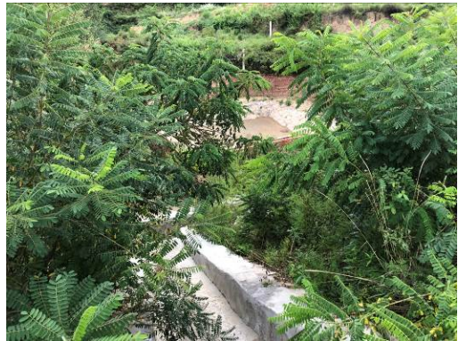
娘子关泉域路段 4#路基收集池
