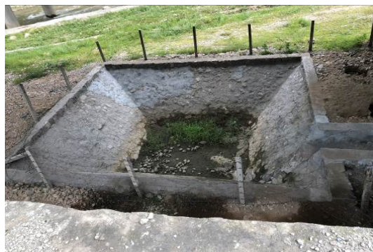
清水河 1 号大桥（右幅）事故水收集池
