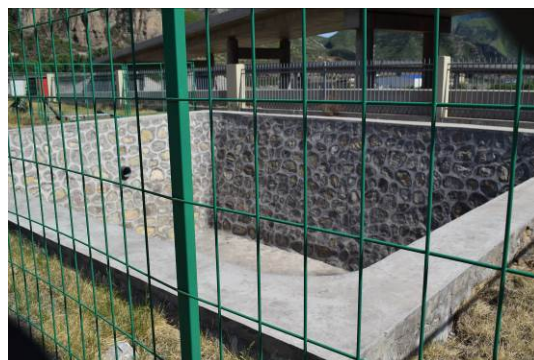
陈家庄停车区东区污水收集池
