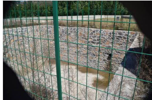
孟县北服务区东区污水收集池
