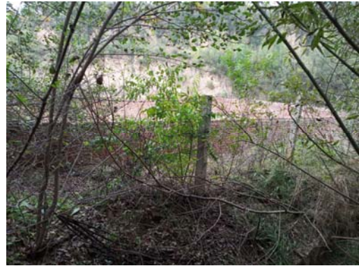
娘子关泉域路段 6#路基收集池
