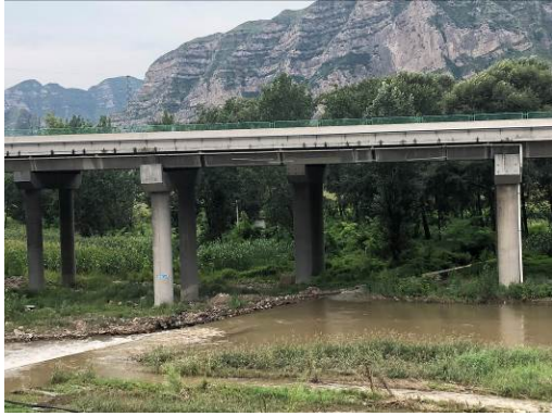
清水河 6 号大桥桥面径流收集系统
