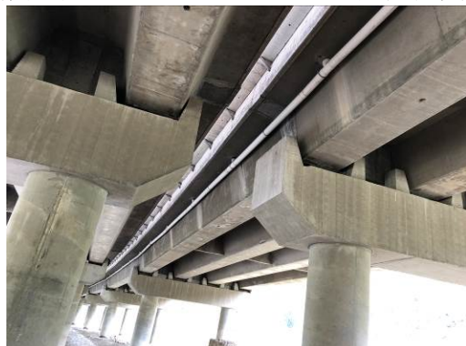
清水河 2 号大桥桥面径流收集系统
