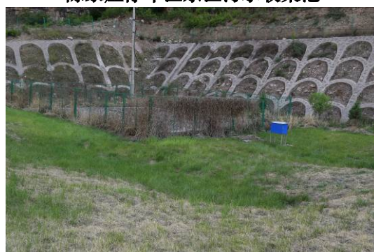
陈家庄停车区西区污水收集池
