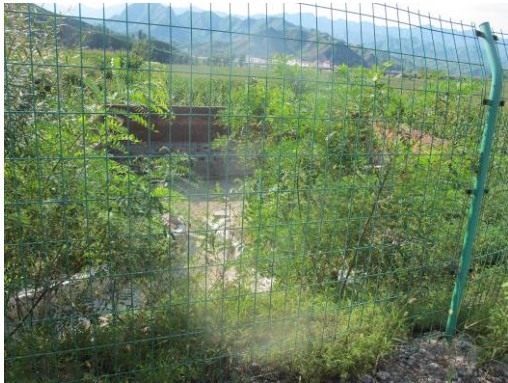
娘子关泉域路段 1#路基收集池
