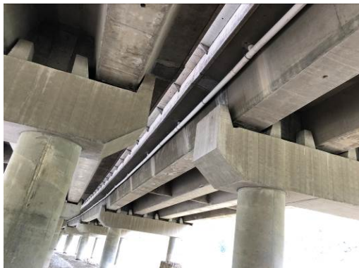
清水河 2 号大桥桥面径流收集系统
