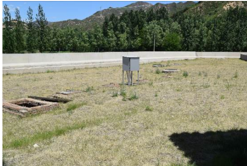
孟县北服务区东区污水处理设备
