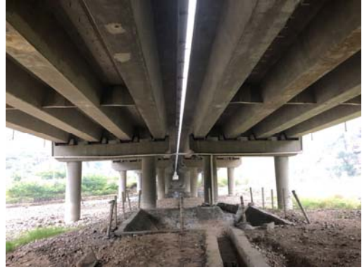
清水河 3 号大桥 3#事故水收集池
