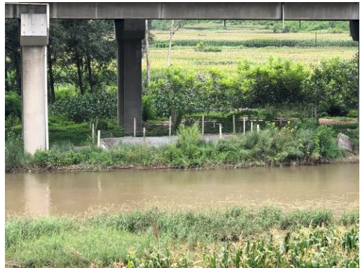
清水河 6 号大桥事故水收集池
