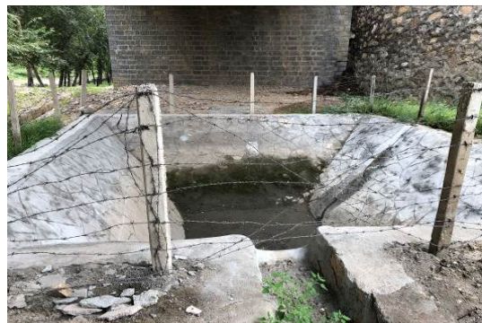
清水河 1 号大桥 (左幅) 事故水收集池
