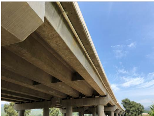
龙华河 2 号大桥桥面径流水收集系统
