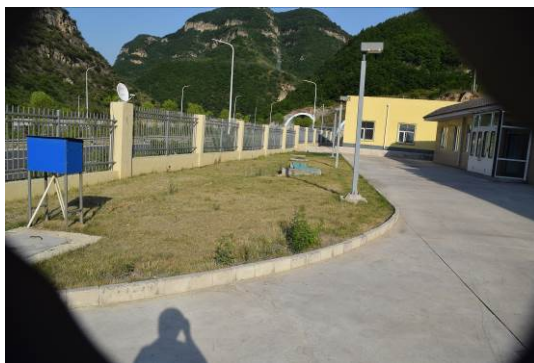
藏山隧道管理站污水处理设备
