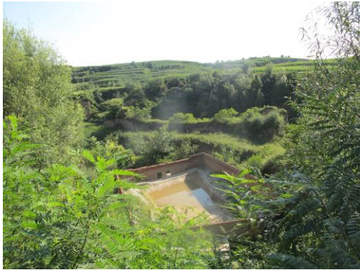
娘子关泉域路段 5#路基收集池
