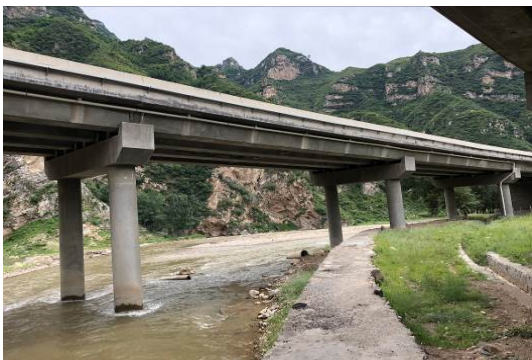
清水河 1 号大桥 (左幅) 桥面径流收集系统
