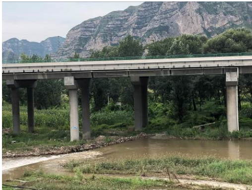
清水河 6 号大桥桥面径流收集系统
