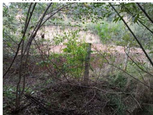
娘子关泉域路段 6#路基收集池
