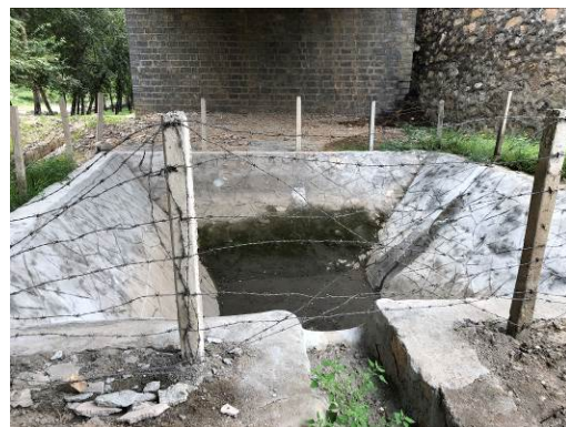
清水河 1 号大桥（左幅）事故水收集池
