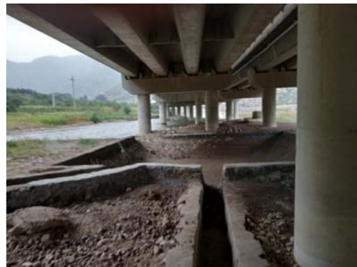
清水河 2 号大桥事故水收集池
