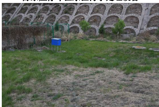
陈家庄停车区西区污水处理设备
