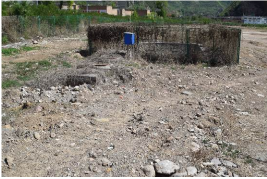
陈家庄收费站污水处理设备
