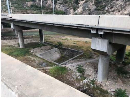
清水河 3 号大桥 2#事故水收集池
