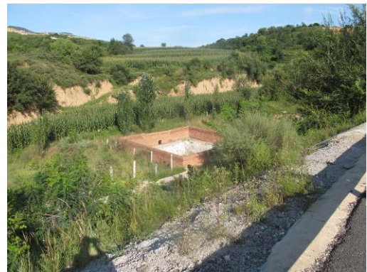
娘子关泉域路段 2#路基收集池
