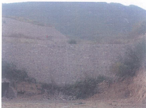
Q1 弃渣场挡渣墙（2017 年 9 月）
