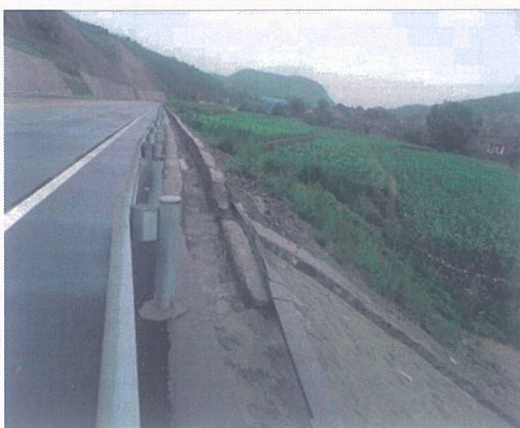
路基边坡巡查
