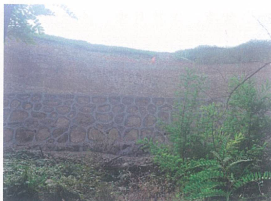
Q7 弃渣场挡渣墙（2017 年 9 月）
