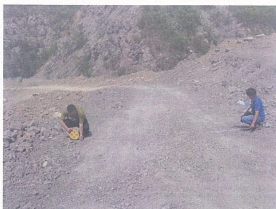
测量施工便道
