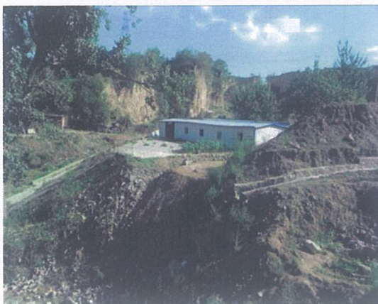
施工迹地调查
