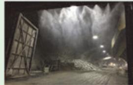
地盤隧道口安裝灑水帷幕，防止挖掘飛塵
