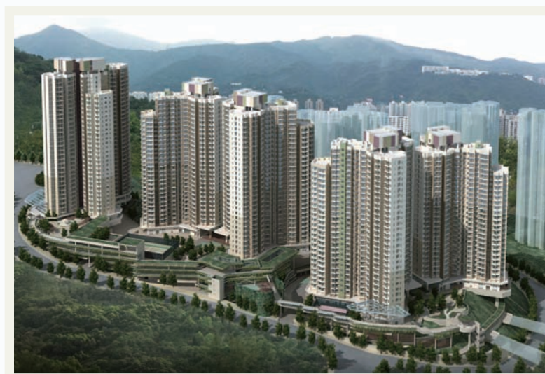
沙田 52 區公共房屋
